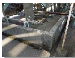
【川崎工場 防液堤】
