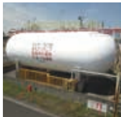
アンモニアタンクの防護フェンス
