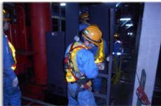
【川崎工場の立体倉庫の月次点検作業時における墜落制止用器具(フルハーネス)の着用の様子】
