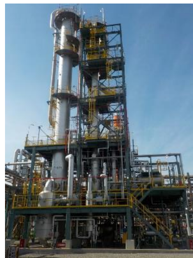
高純度アリルアルコール第2プラント
